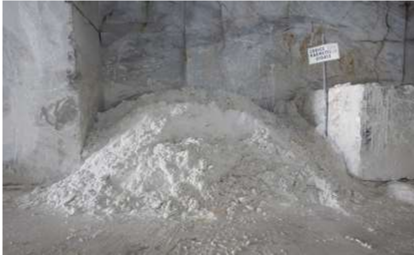
Foto 3 - Tavolini B; accumulo di rifiuto “marmettola” (cod. CER 010413) posto sul pavimento della galleria e non correttamente stoccato all'interno di un predisposto contenitore.
