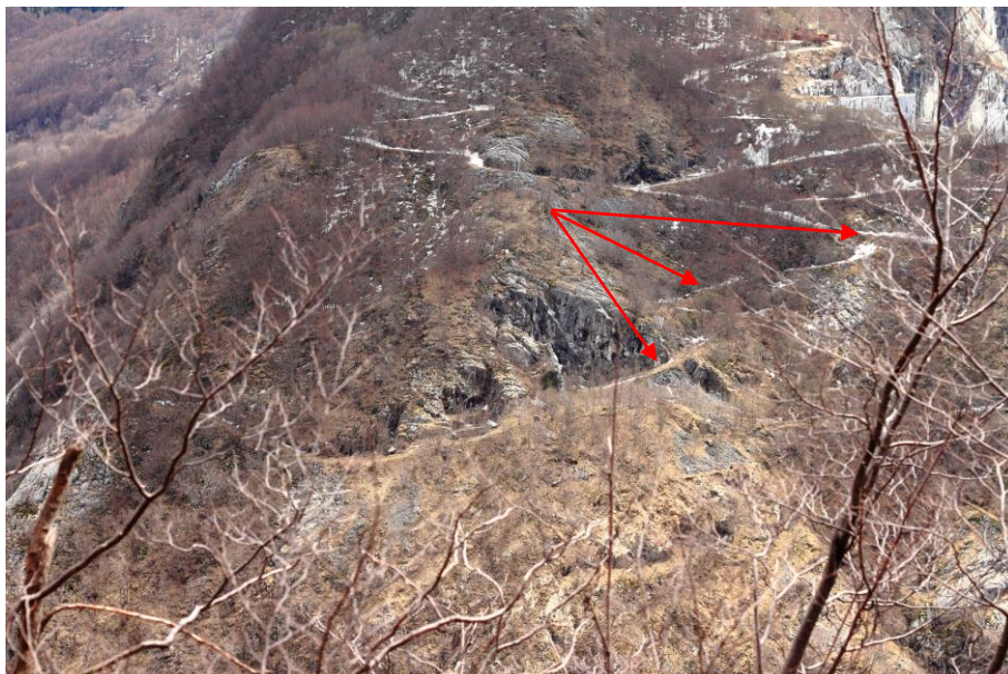
Foto 2. Scatto effettuato come il precedente in data 06.04.2018 da sentiero per Eremo di S. Viviano in cui si vede la viabilità che dalla strada per i cantieri alti di cava Piastrabagnata scende all'interno di cava Suspiigionica indicata dalle frecce.-
