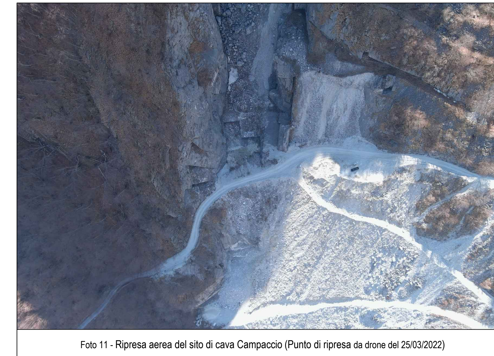
Foto 11 - Ripresa aerea del sito di cava Campaccio (Punto di ripresa da drone del 25/03/2022)
