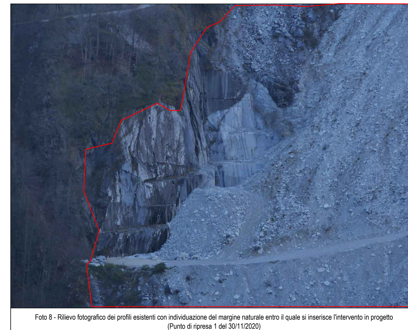
Foto 8 - Rilievo fotografico dei profili esistenti con individuazione del margine naturale entro il quale si inserisce l'intervento in progetto (Punto di ripresa 1 del 30/11/2020)
