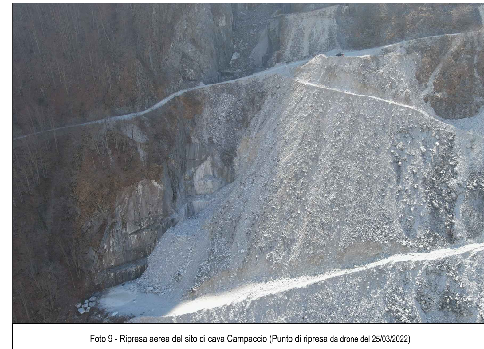
Foto 9 - Ripresa aerea del sito di cava Campaccio (Punto di ripresa da drone del 25/03/2022)
