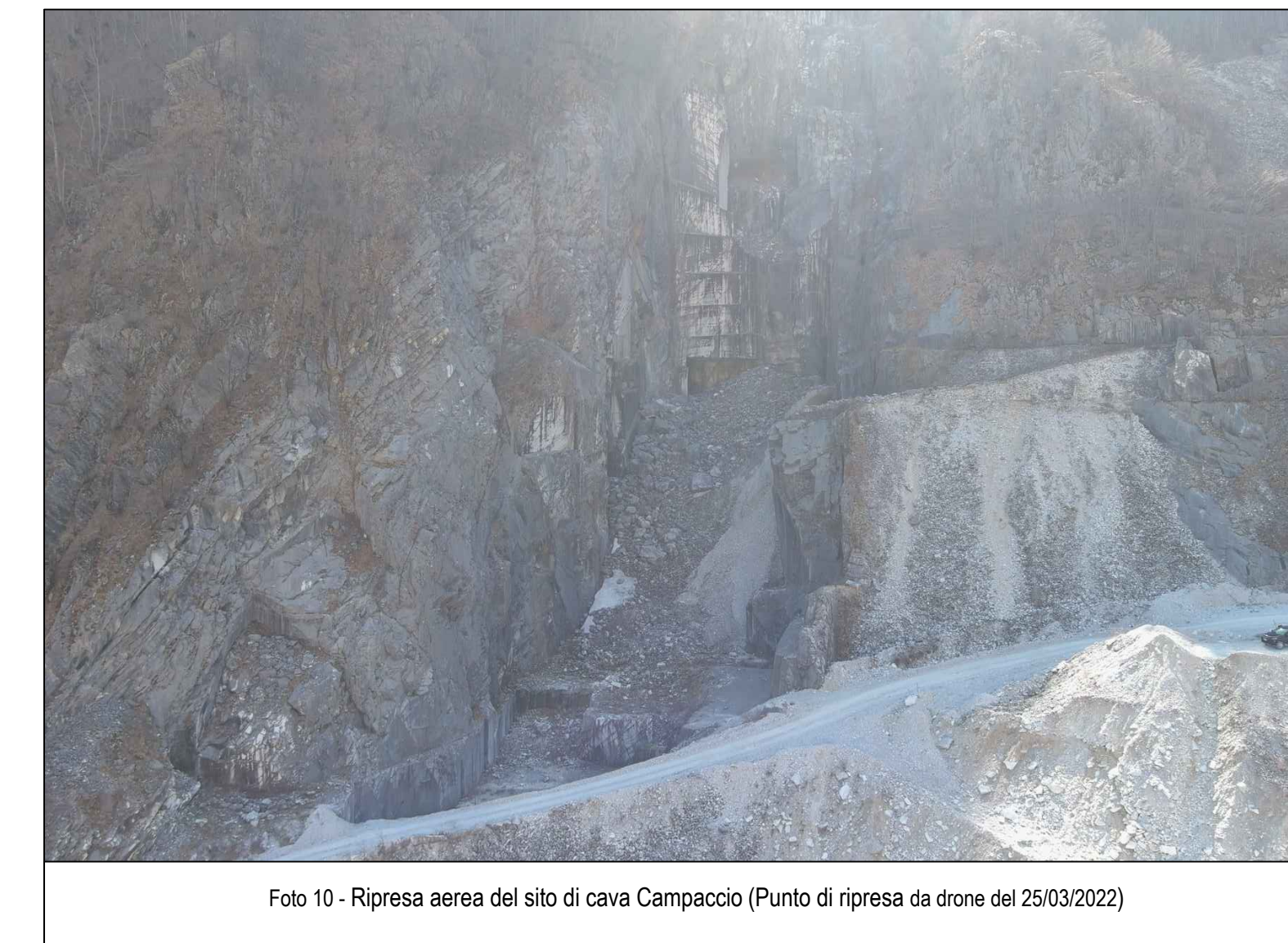
Foto 10 - Ripresa aerea del sito di cava Campaccio (Punto di ripresa da drone del 25/03/2022)
