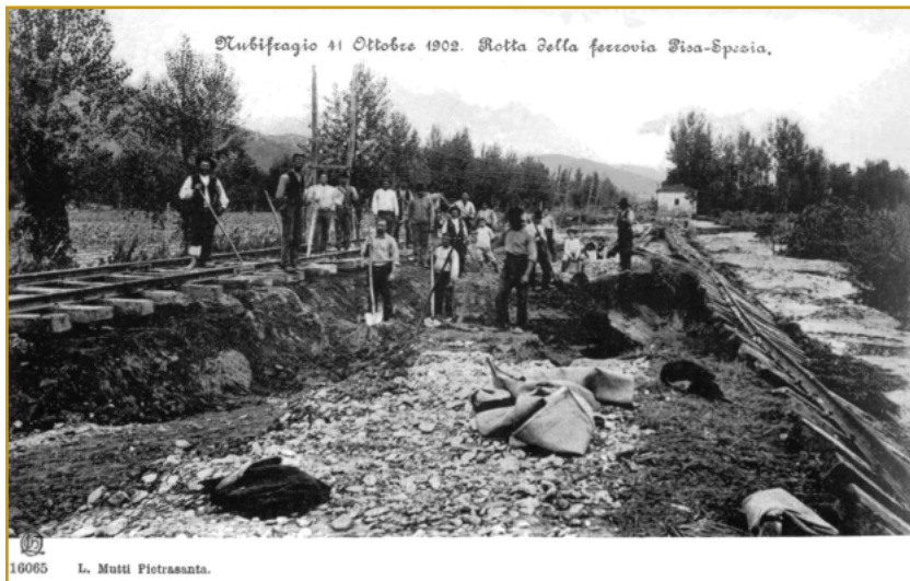
25 - Ponterosso: danni alla ferrovia Pisa-La Spezia damage to the Pisa-La Spezia railway
