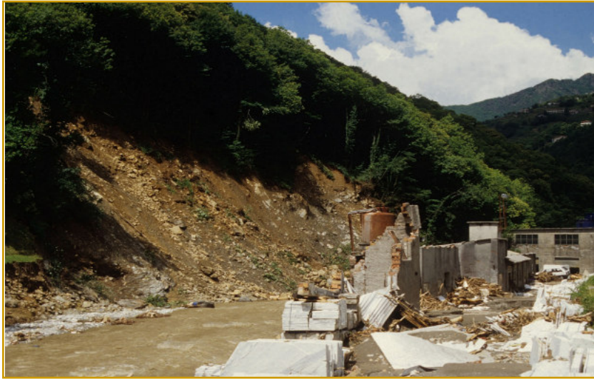
44 - Fornetto: danni a un laboratorio di marmi e frana a bordo fiume damage to a marble factory and landslide on the river bank
