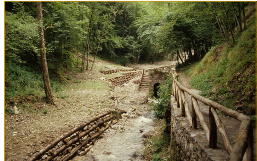
54 - Petroscciana: ricostruzione di argine e restauro di sentiero bank reconstruction and footpath restoration
