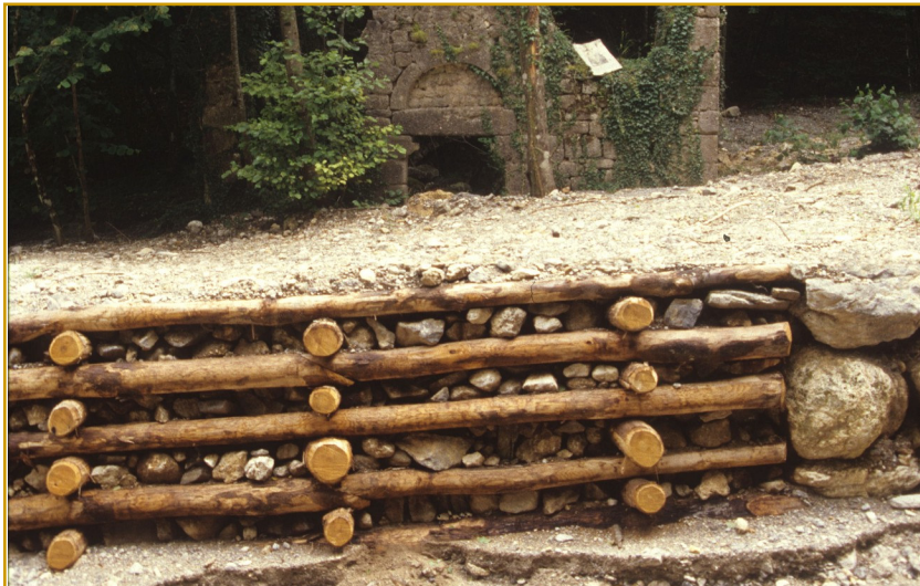
53 - Petroscciana: palificata doppia a protezione della "Chiesaccia" soil bioengineering work for protection of the "Chiesaccia" oratory remains
