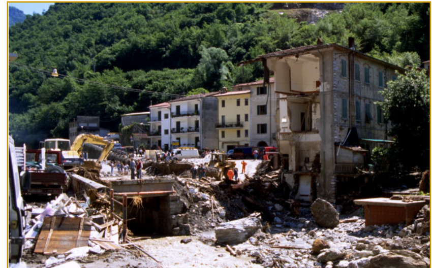
43 - Pontestazzemese: danni della piena del torrente Cardoso damage caused by the Cardoso stream overflow
