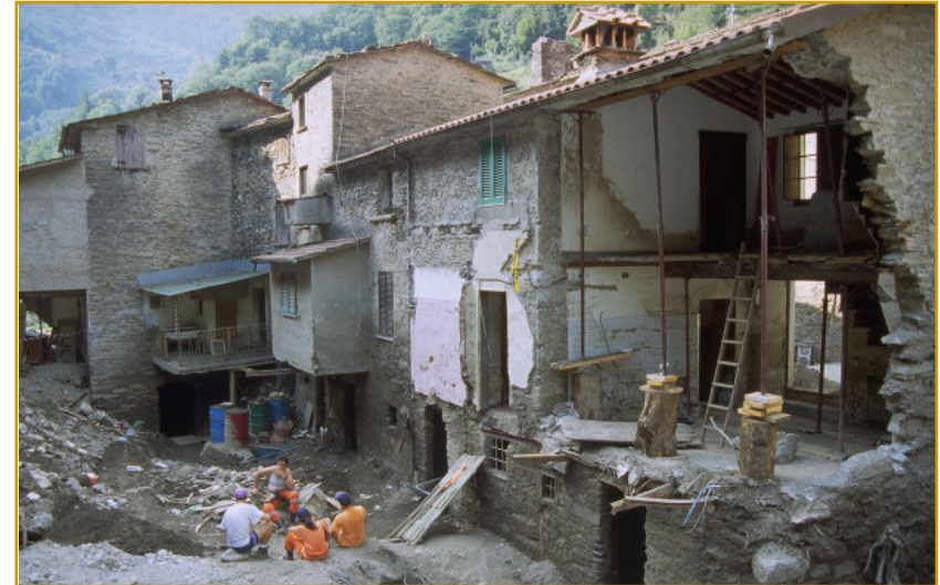
41 - Cardoso: una breve pausa durante la fase di primo intervento a short break during the first intervention phase
