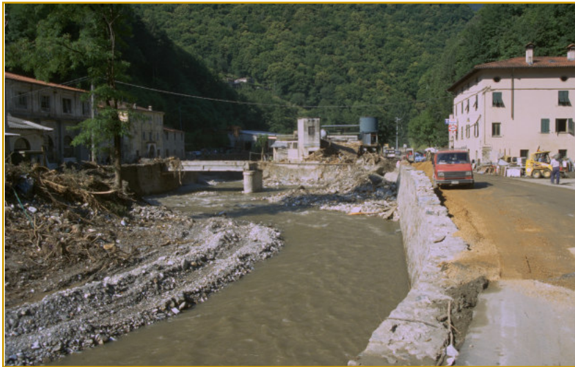
46 - Argentiera-Zarra: il vecchio centro minerario isolato dal ponte distrutto the old mine centre isolated by the destroyed bridge
