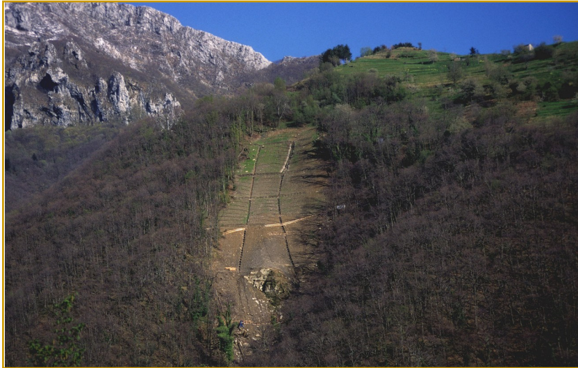
51 - Pomezzana: stabilizzazione dell'area di distacco di una frana stabilisation of a landslide detachment area
