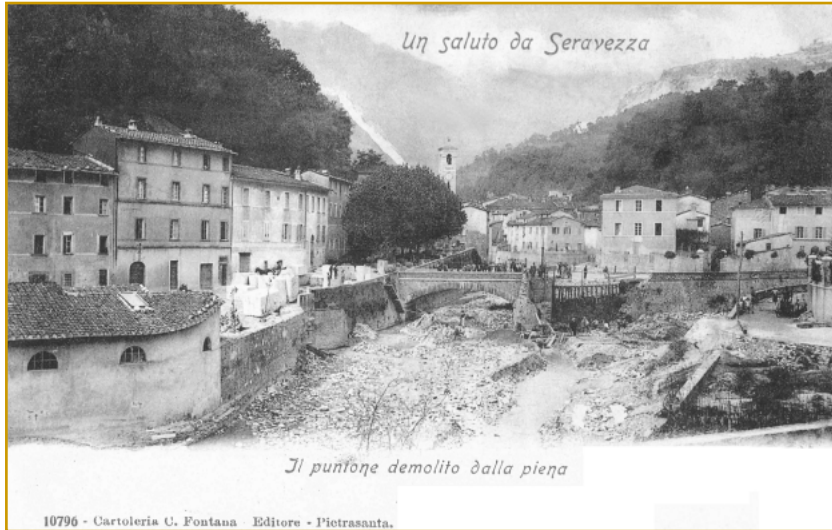
23 - Seravezza: l'argine distrutto dalla piena bank destroyed by the flood
