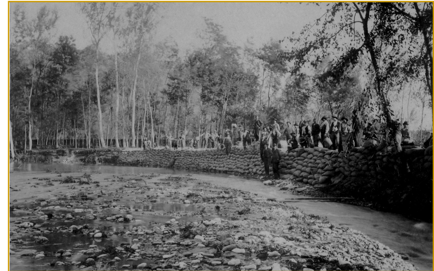
24 - Ponterosso: sistemazione precaria della rotta del fiume temporary restoration of the river bank breach
