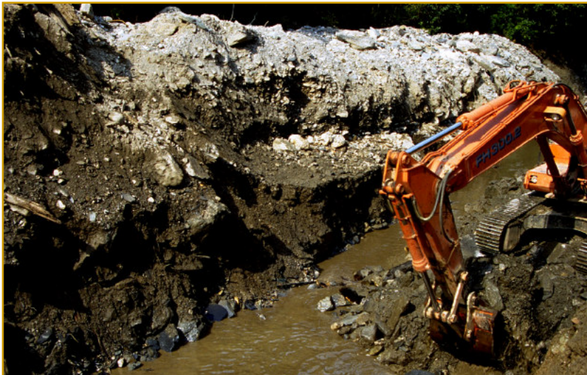
9 - Cardoso: l'ingente spessore dei detriti nell'alveo sov ralluionato the remarkable thickness of debris along the aggraded riverbed
