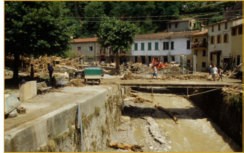
45 - Ruosina: il Canale di Cansoli con la sua scia di detriti vegetali trail of vegetal debris floated by the Cansoli stream
