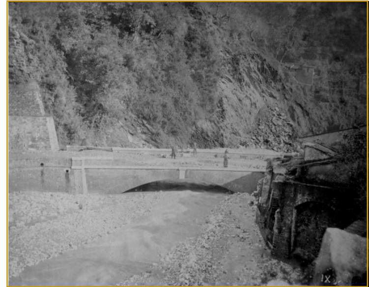
14 - Riomagno: "ponte nuovo di Riomagno" the new bridge in Riomagno
