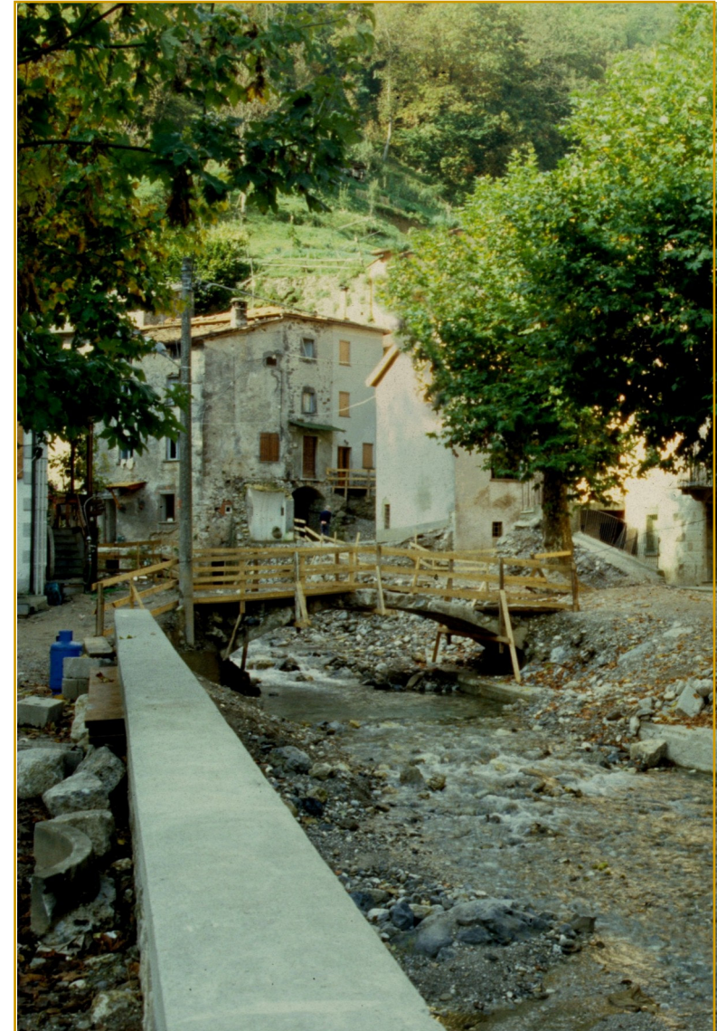
39 - Fornovolasco: il vecchio ponte della piazza the old bridge in the square
