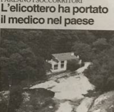
Il ristorante della Grotta del Vento, con il posteggio distrutto dall'alluvione (fotoservizio Borghesi)
