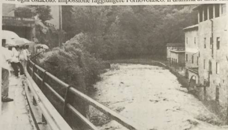
Il torrente Turrone di Gallignano in piena ha provocato diverse lesioni alle case lungo il corso come si vede in questa foto. Numerose le famiglie che hanno dovuto lasciare la loro casa.
