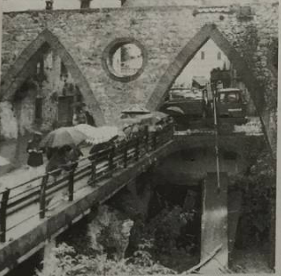
A Galliano si lavora per liberare l'alveo del torrente in piena, che ha trascinato con sé anche un ponte (foto Placido)
