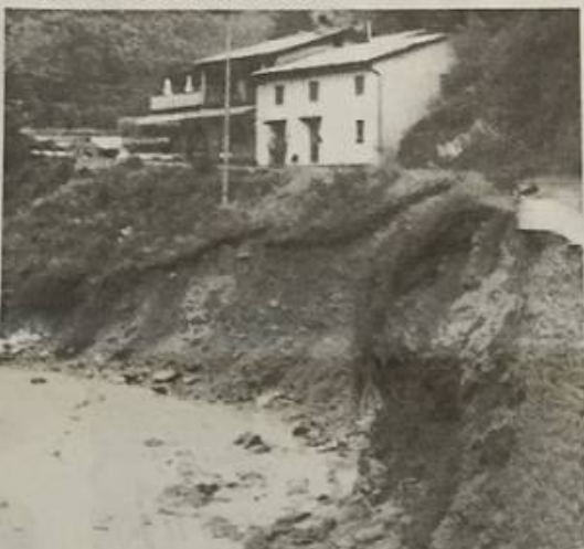
Un'immagine di una delle frane che hanno portato via la strada fra Gallignano e Vergemoli
