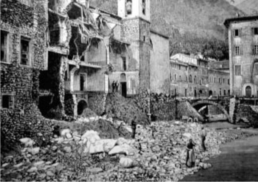
Fig. 8 - Danni prodotti a Seravezza dalla piena torrentizia verificatasi nella notte tra il 25 e il 26 settembre 1885 (da L'Illustrazione Italiana, 1885).
