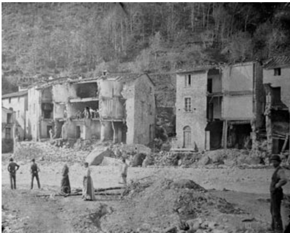
Fig. 6 – I danni alle abitazioni di Riomagno di Seravezza, provocati dalla “piena” del 1885
