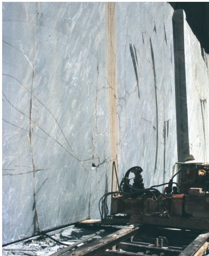
Figura 3b - Particolare di taglio orizzontale alla base della bancata realizzata con una tagliatrice a catena.
