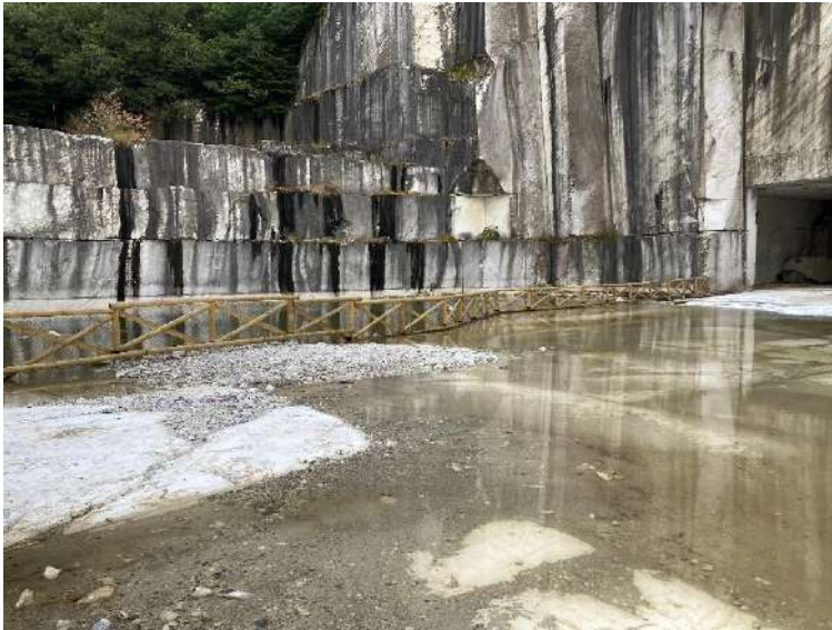
staccionata in legno
