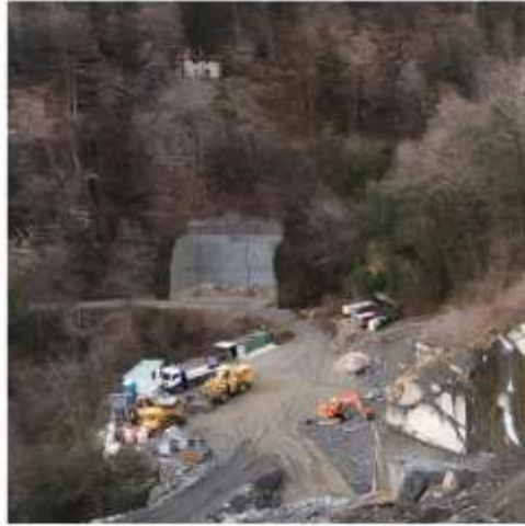
Stato ripristino (inizio prima del rinverdimento)
