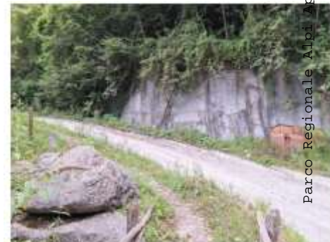
Vista Settore 3 da viabilità di comparto
